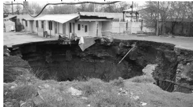
Рисунок 4 – Провал на устье старого шахтного ствола (фото А.Н. Феофанова, 2007 г.)
