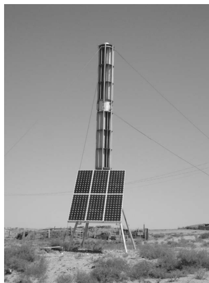
Ветровые роторные турбины Болотова с солнечными преобразователями на удаленных объектах Казахтелекома
