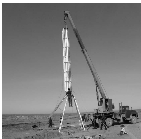
Монтаж двухмодульной вертикально осевой ветровой роторной турбины ВРТБ
