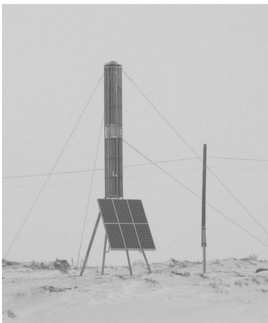
Энергосистема при питании автономного объекта «Ажар», Кызылординская область
