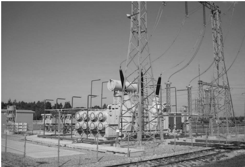
Рисунок 2 - Управляемый шунтирующий реактор на ОРУ-330 кВ Игналинской АЭС
