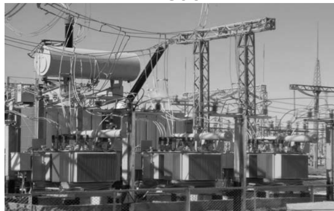
Рисунок 4 - Система подмагничивания УШР на фоне электромагнитной части РТДУ-180000/500 ПС «Агадырь»
