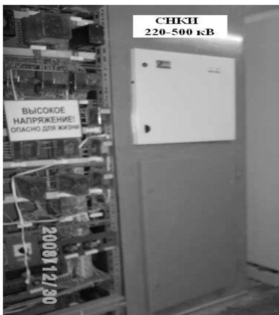
Рисунок 3 – Блок БРКУ «Нева» в шкафу СНКИ 220-500 кВ в ОПУ ПС «Ульке 500 кВ»
