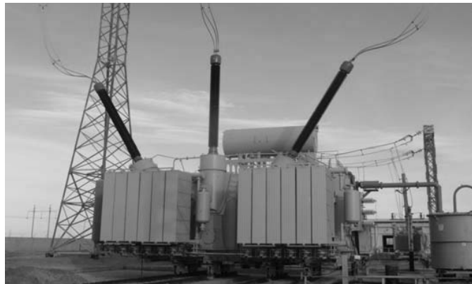
Рисунок 3 - Управляемый шунтирующий реактор на ПС-500 кВ «Агадырь» АО «KEGOC»
