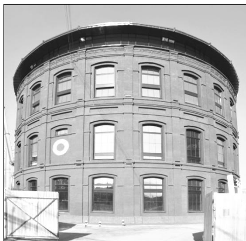
Рис. 6. Газгольдер 17 после реконструкции (фото автора).
