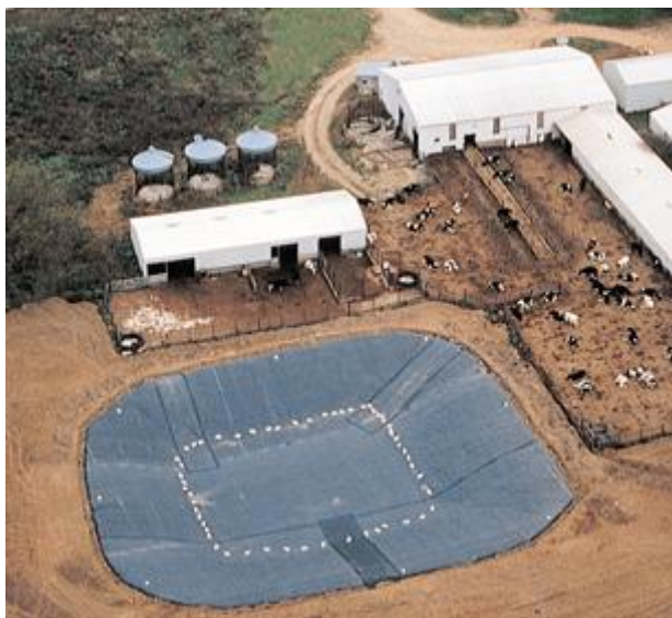
Рис. 2. Строительство солнечного пруда рядом с молочной фермой. Вид сверху
