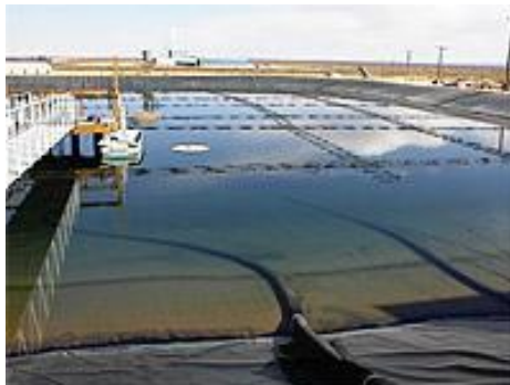
Рис. 4. Дно Солнечного пруда из глины и полиэтилена
