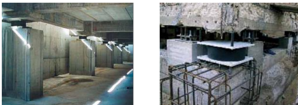
Рис. 6. Пример использования резинометаллических (эластомерных) изоляторов
