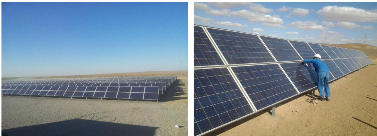
Рис. 4. Солнечная электростанция «Жанакорган»
