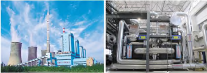
Рисунок 1, 2 – Общий вид электростанции Шенту и установленной ТНУ
