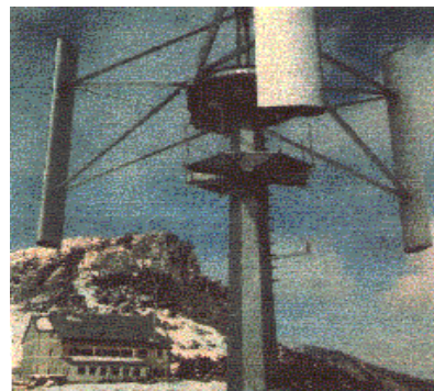
ә) Тік қалақшалы Дарье жел турбины.
