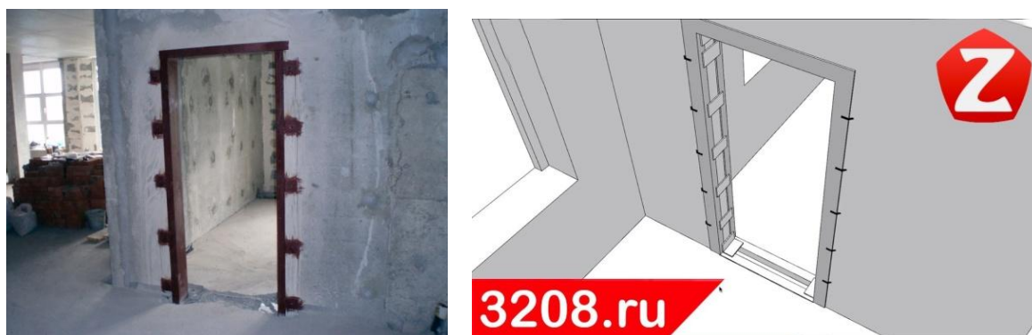
Рис. 1.2. Пример усиления дверных проемов в диафрагмах жесткости
