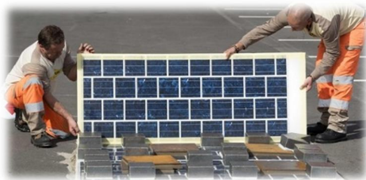
Рис. 1. Монтаж дорожного полотна из солнечных панелей от компании «Colas»
