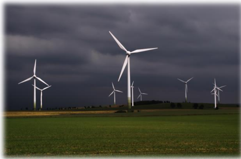
Сурет 3 – Жел электростанциясы
