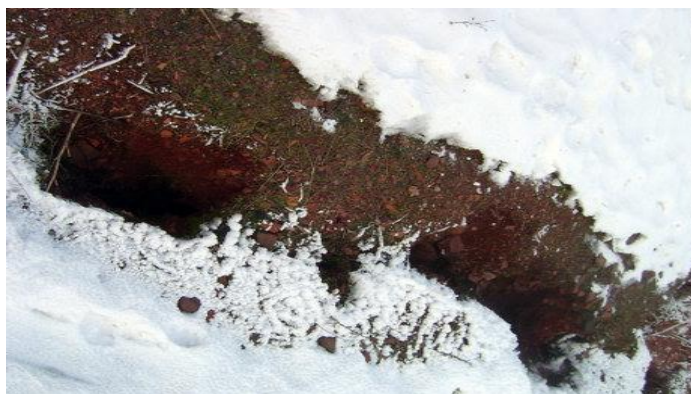
Фото 4. Выход глубоких трещин в теле террикона
