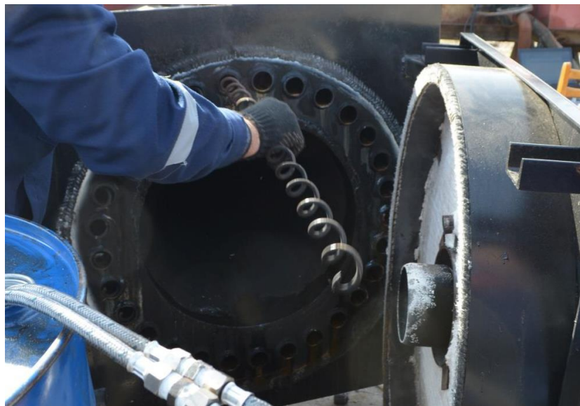
Рисунок 3 – процесс вставки спиралевидных вставок из стальной проволоки в жаровые трубы котла ВВ-400 в трубы \text{Ø}48 \times 4
