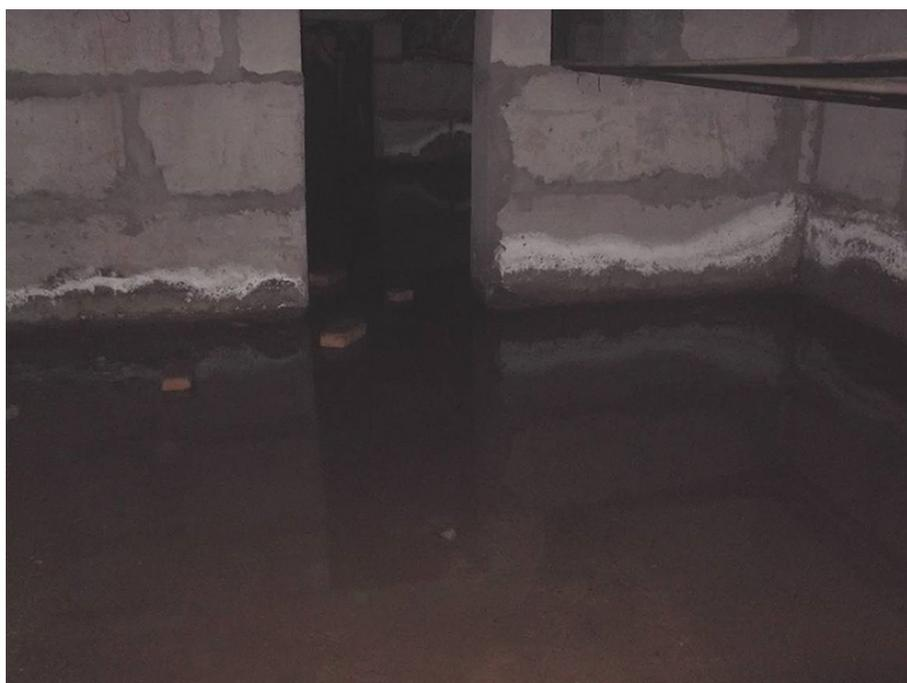
Рисунок 2 – Участок подтопления цокольной части дома (на 26.06.2012г.) в осях «10-12, Д-К»
