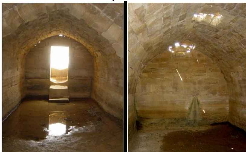
Овдан. Вид скального овдана изнутри в направлении входного проема, в противоположном направлении видны осветительные проемы и дренажное отверстие / Северный Гобустан
