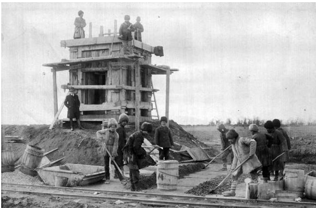
Строительство Баку-Шолларского водопровода. Начало XX века
