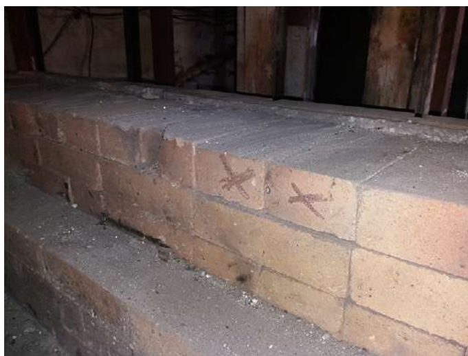
Рисунок 3 – Кладка опытных кирпичей в руднотермической печи
